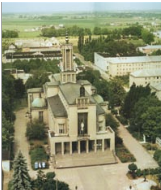
Bazylika pilnie potrzebuje remontu elewacji i otoczenia
