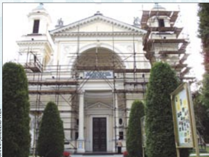
Zabytkowy kościół w Wilanowie otrzyma 30 tys. zł na dokończenie prac remontowych
