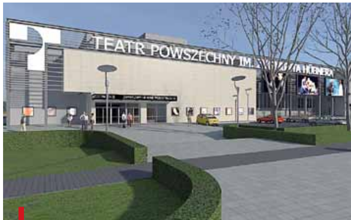
Koszt remontu to około 28 mln zł. Część inwestycji finansuje Unia Europejska
