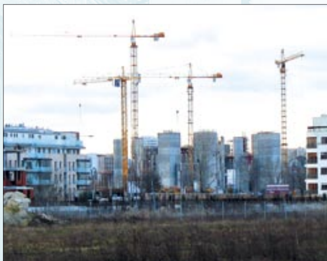
Budowa świątyni posuwa się wolno
