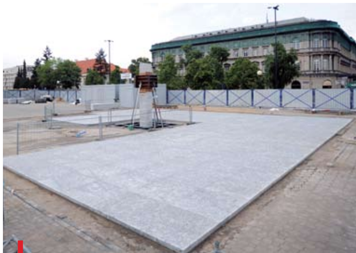
Montaż czterech kamiennych elementów pomnika potrwa do końca maja
